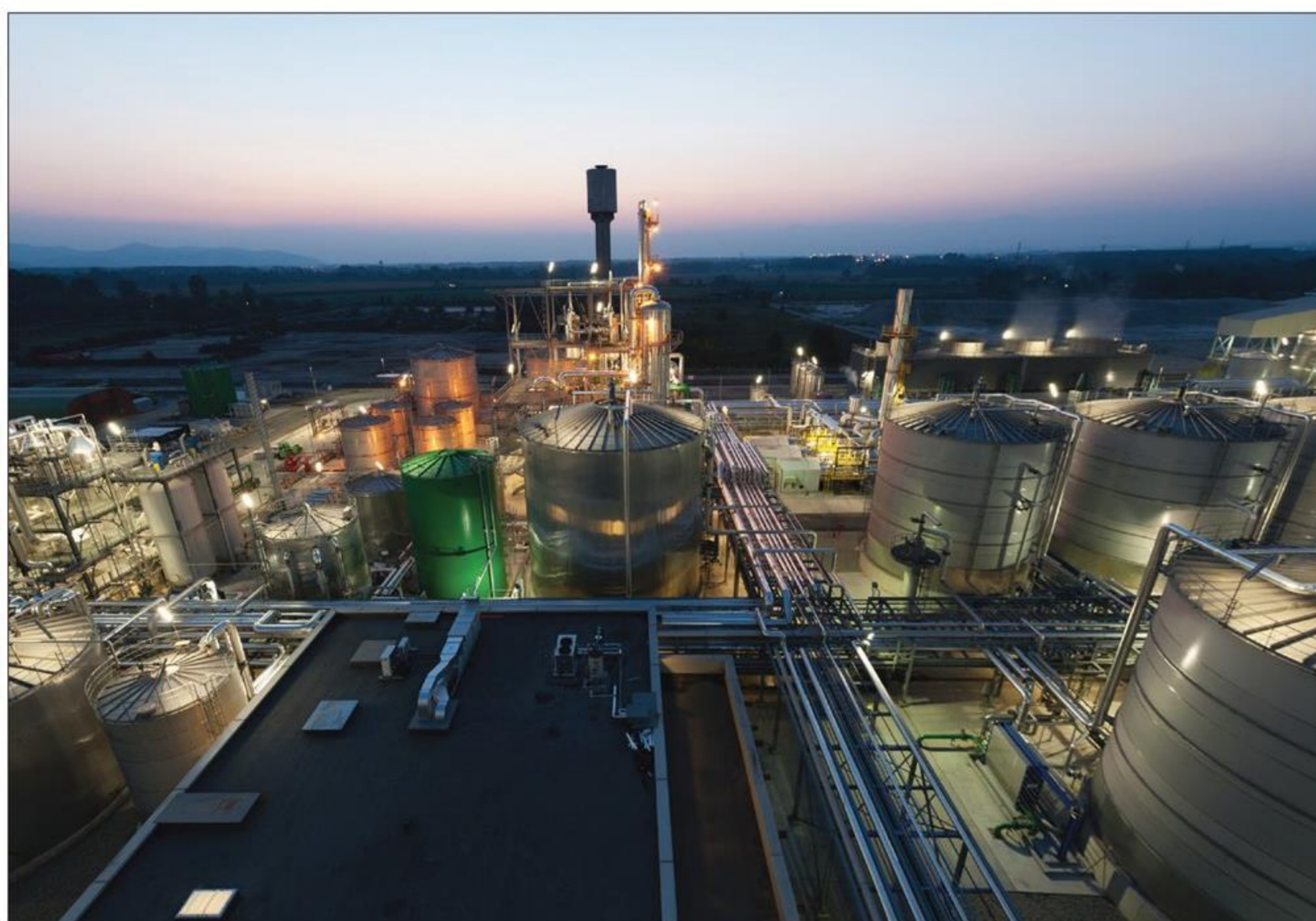
Anlægget ved Crescentino.
